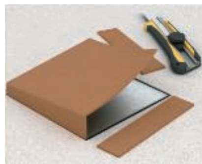
Отваряне след дейностите със замазката С помощта на нож отворете покритието от картон и премахнете монтажния защитен капак.
