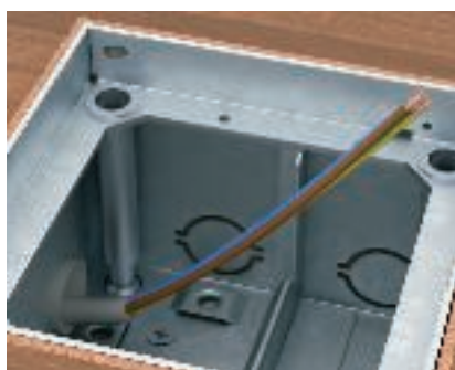
Подготовка на свързващия проводник за контакти Подгответе свързващия проводник за контакт.
