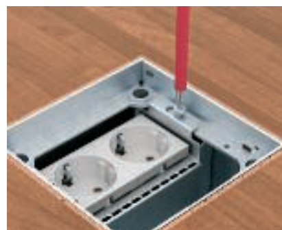
Закрепване на носача. Поставете металния носач GE2V и го закрепете.
