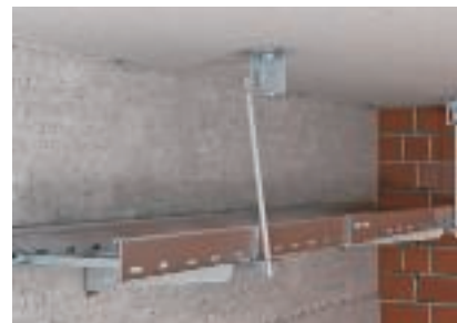
Закрепване към тавана на носещите шпилки към тавана с противопожарна скоба
