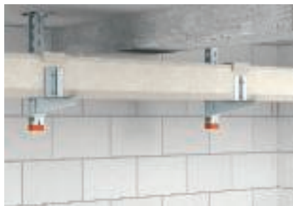
Окачен монтаж към тавана като I-канал
