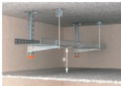
Необходимо минимално отстояние до противопожарния таван
