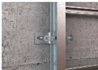
Монтаж със закрепващи винкели
