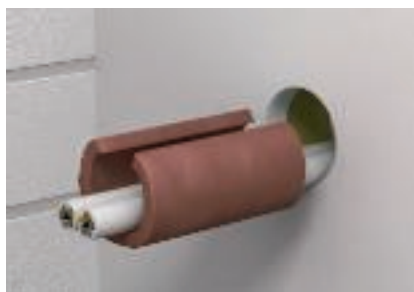
Прорязване на тръбните обвивки при вече поожени кабели
