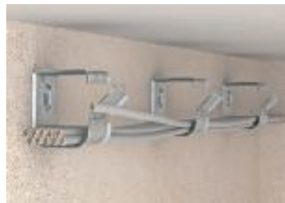
Лесен монтаж на кабели в отворената събирателна скоба
