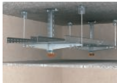
Таванен монтаж на две нива с двустранни конзоли
