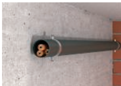
Полагане на повече кабели съгласно данните в протоколите от изпитание
