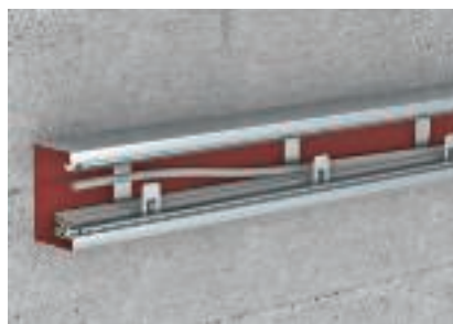
Придържачи скоби като помощ при монтажа срещу падане на кабелите
