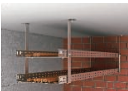
Таванен монтаж на две нива чрез скоба за окачване и удължител
