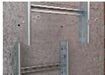
Изпълнение с надлъжно съединение без съединител
