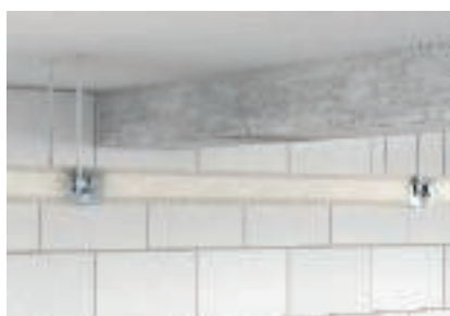
Окачен монтаж през свързващите елементи
