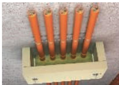
Осигуряване против опън чрез ZSE90
