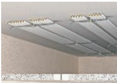
Таванен монтаж над окачен противопожарен таван
