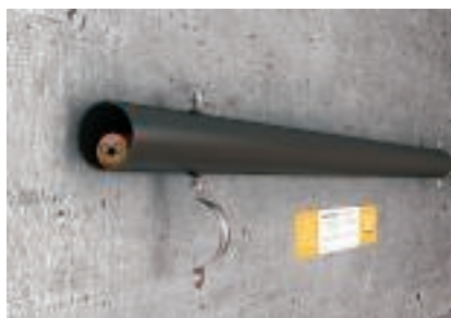
Полагане в дистанционна скоба чрез закачване на горната част към болта
