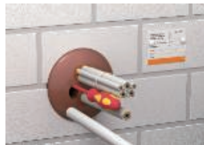
Допълнителна инсталация след внимателно отрязване или пробиване на тапите
