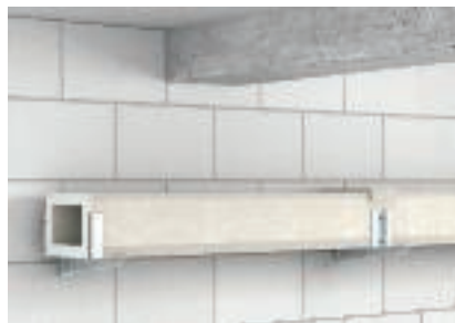
Монтаж на стена като I-канал
