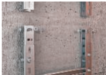
Надлъжно съединение със съединител с болтова връзка
