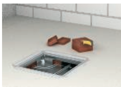
Отрязване на тясна лента за канални секции
