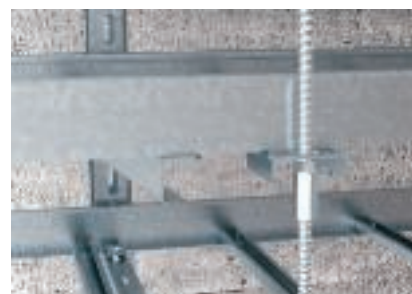
Монтаж на осигуряващи носещи шпилки при разположение на няколко нива
