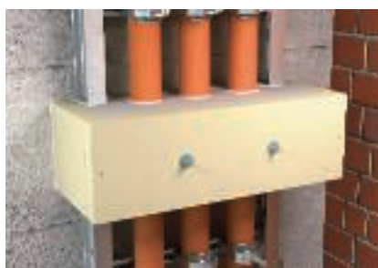
Ефективно осигуряване против опън чрез ZSE90
