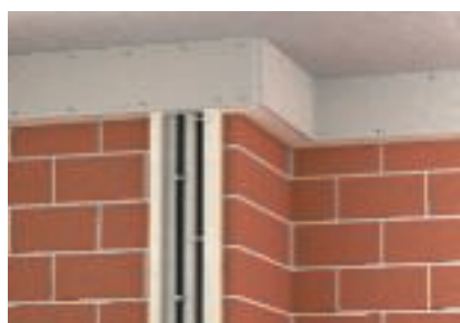
Закрепване на кабелите със скоби при вертикален монтаж на каналите
