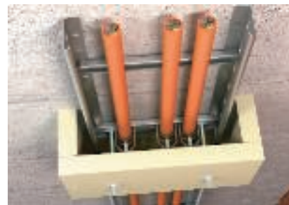
Монтаж на елемента в комбинация с вертикални кабелни стълби
