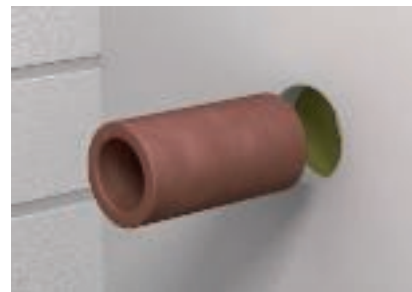
Поставяне на тръбна обвивка в леката преградна стена
