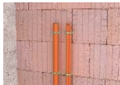
Вертикален стенен монтаж на кабели отделно или в сноп
