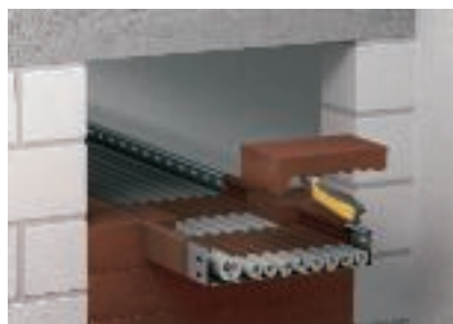
Монтаж на прорязани блокчета
