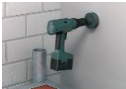
Разпробиване на отвор
