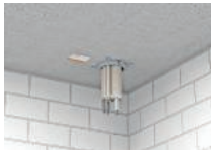
Монтаж към долната страна на тавана с метални дюбели
