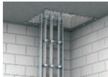
Обезопасяване срещу падане при монтаж в таван
