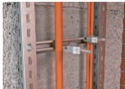
Закрепване на кабели поотделно или като сноп с BBS-скоба
