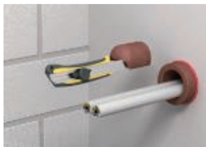
Отрязване и поставяне на тапа в тръбната обвивка
