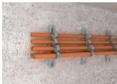
Хоризонтален монтаж на кабели с BBS-скоби към стена
