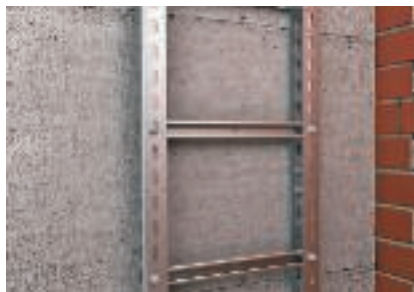
Директен монтаж на вертикални кабелни трасета върху масивна стена
