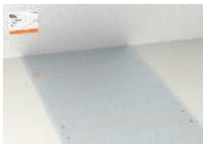
Незабележима преграда в равнини със замазката подподови канали
