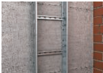
Директен монтаж на вертикални кабелни стълби върху масивна стена
