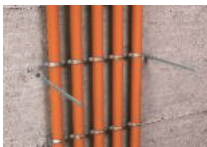
Закрепване директно върху стената непосредствено до кабелите
