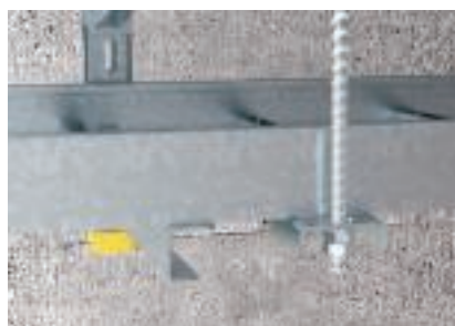
Свързващ елемент на разстояние максимално 100 mm от конзолата
