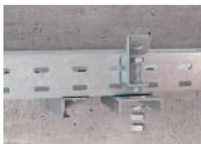
Закрепване на наклонения съединителен елемент
