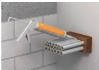
Финишно затваряне на фугите след окончателното полагане на кабелите
