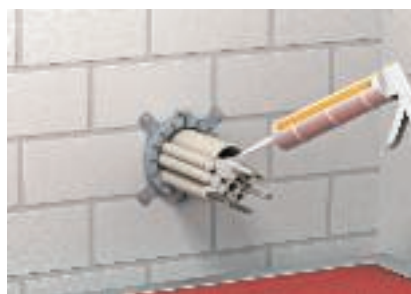
Уплътняване на краищата на тръбите с противопожарна смес DSX
