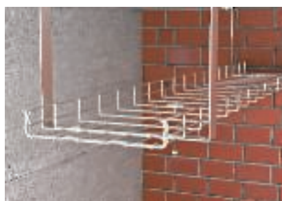
Закрепване на телена скара с клемен съединител и болт с обла глава
