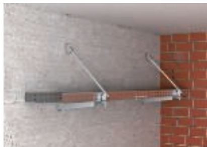
Стенен монтаж с косо разположени носещи шпилки
