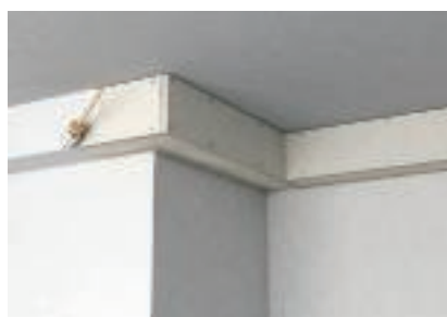
Довършителна обработка на повърхностите чрез боядисване или облицоване
