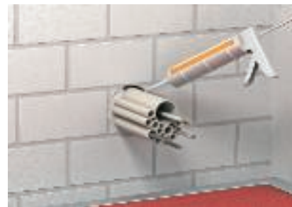
Запълване на фугите с раздуваща се противопожарна смес DSX
