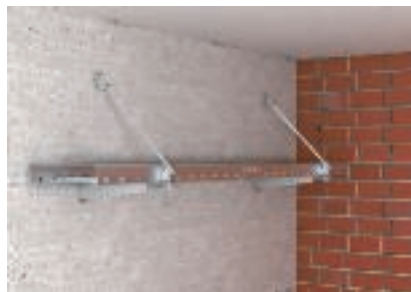
Стенен монтаж с косо разположени носещи шпилки
